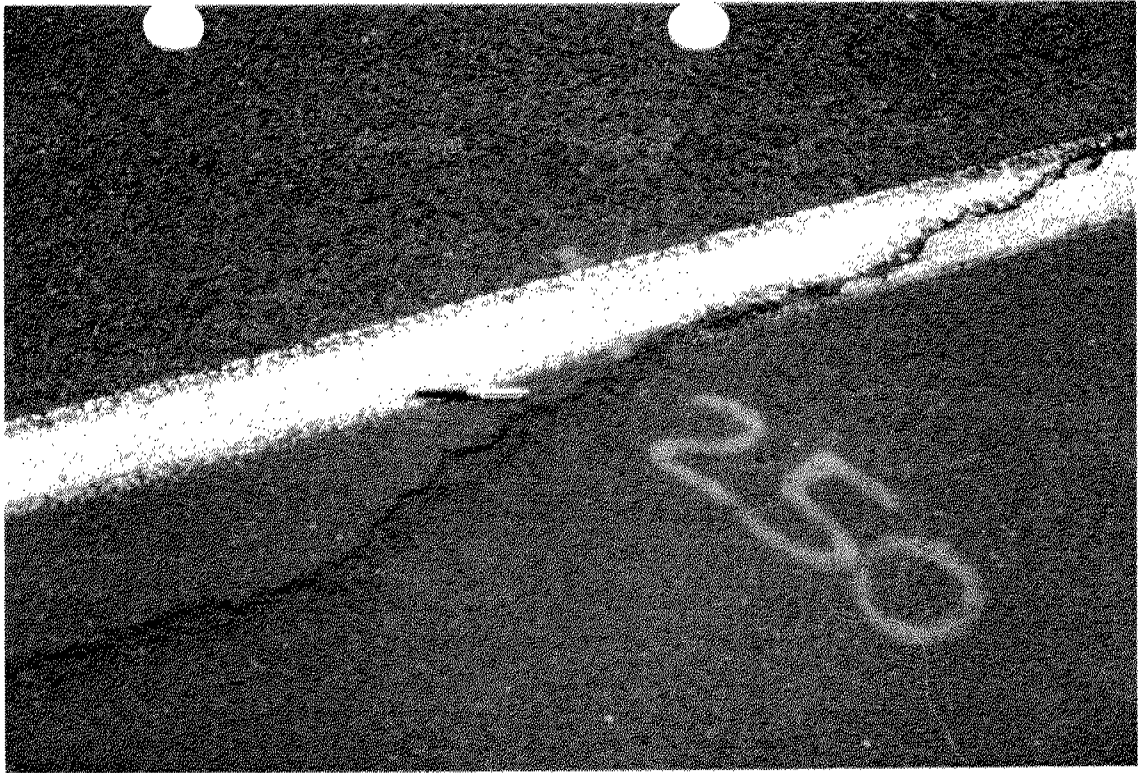
Very severe longitudinal meandering outside edge cracking Sta 10+250 N.B.L
